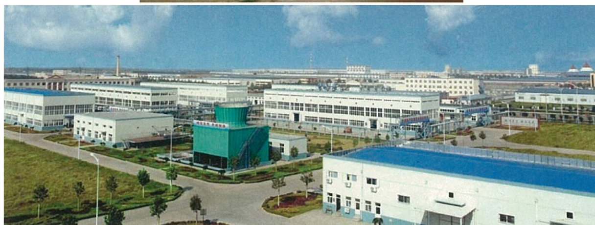
図-2 本研究の成果に基づき製薬工場に建設した4つの 2,800m 3 UASB 反応槽
