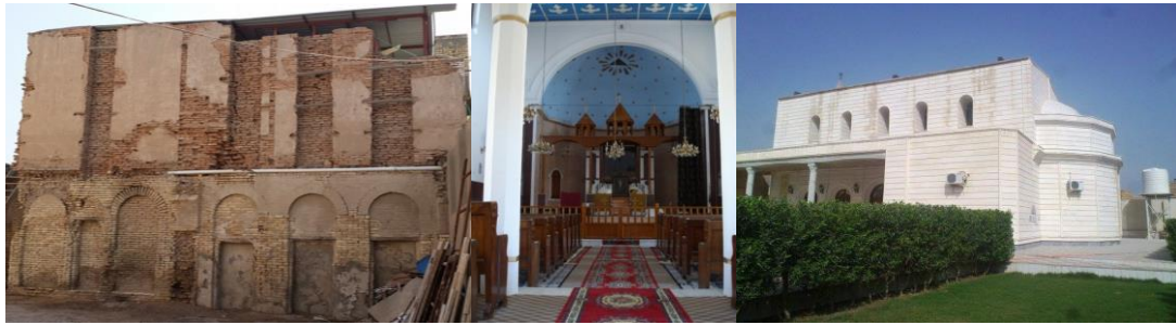
الشكل (8) تفاصيل الهيكل الانشائي للاجزاء التابعة لكنيسة الارمن (مدرسة الارمن) قبل تهديمها يبين فيها استخدام حديد الشلمان مع الاخشاب (السيوره) والحصران/ النقوش في مدخل الكنيسة من الاجر المنقوش بطريقه جميلة المصدر (الباحث)
