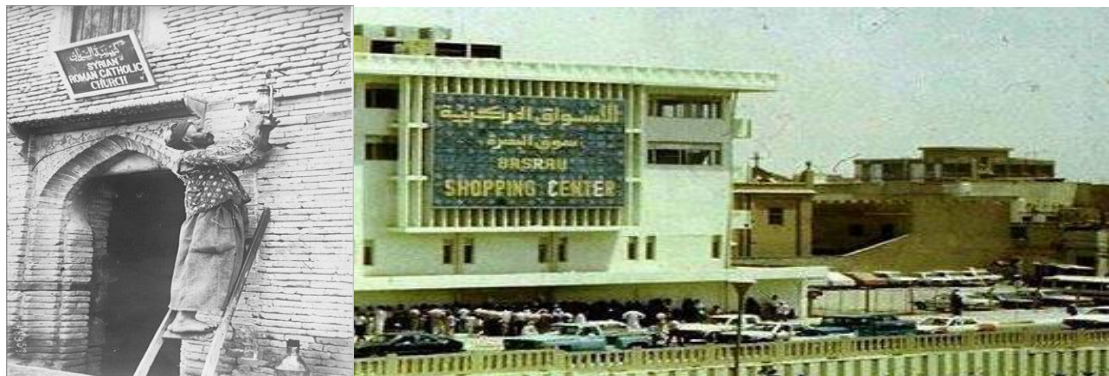
الشكل (15) كنيسة العذراء في العشار وبجانبها بناية الاسواق المركزية 1986\مدخل كنيسة السريان الرومان 1919
