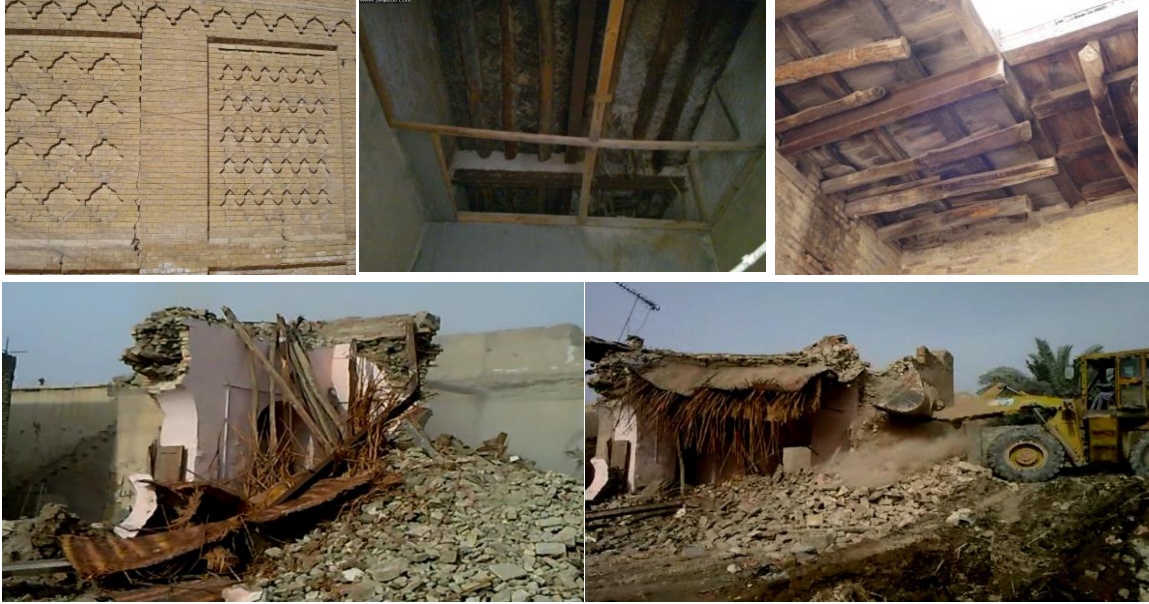
الشكل (8) تفاصيل الهيكل الانشائي للاجزاء التابعة لكنيسة الارمن (مدرسة الارمن) قبل تهديمها يبين فيها استخدام حديد الشلمان مع الاخشاب (السيوره) والحصران/ النقوش في مدخل الكنيسة من الاجر المنقوش بطريقه جميلة المصدر (الباحث)
