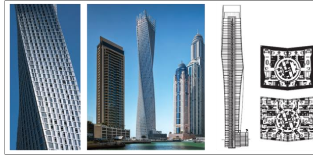
الشكل (20) صور توضح مخططات ومقطع والشكل الخارجي لمشروع برج Infinity [33, p. 173,177].
