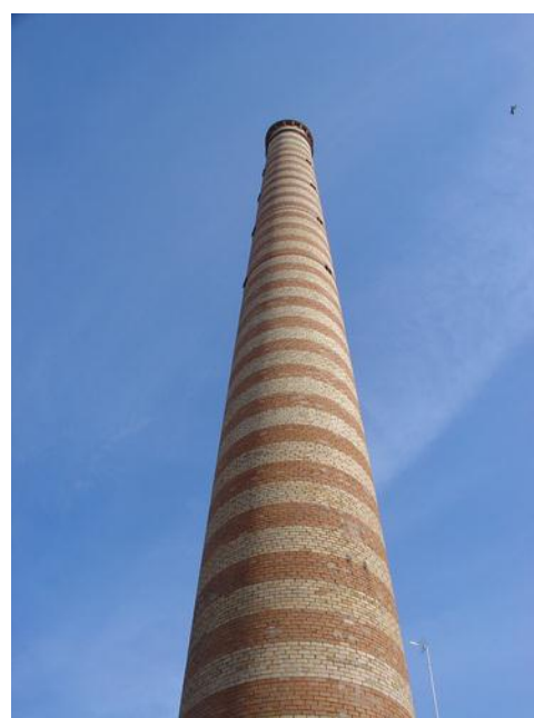
Vista actual de la chimenea de la antigua fábrica de Yute.
