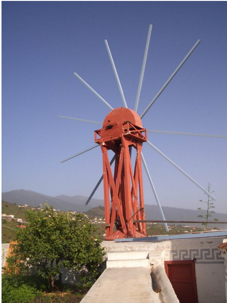
Figura 3. Molino de viento harinero "Sistema Ortega" en Monte Pueblo. TM de la Villa de Mazo. La Palma. Fotografía: Víctor M. Cabrera García
