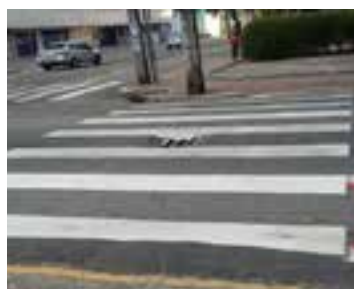
Bueiro na travessia
