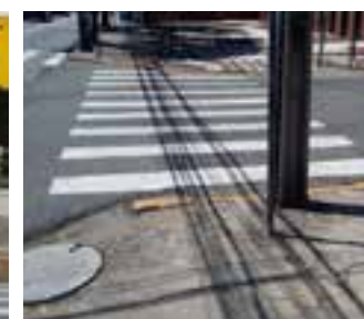
Travessia sem rampa e obstruída por poste.
