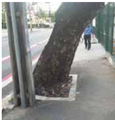
Passeio com dimensão inadequada - árvore obstruindo a passagem.
