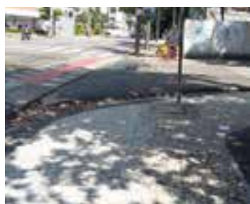
Rua desnivelada, sem rampa de acesso, com obstáculo e lixo na travessia.
