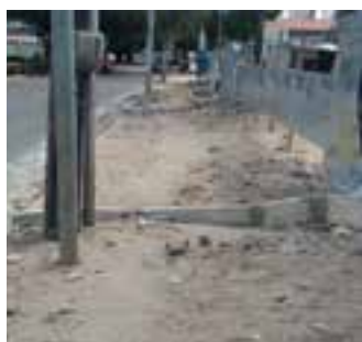
Obra tomando o passeio
