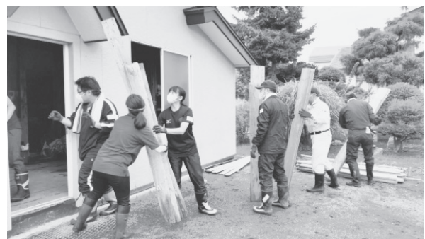
写真2 家財搬出作業
