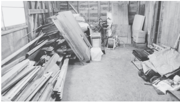
写真4 家財搬入・原状復帰作業
