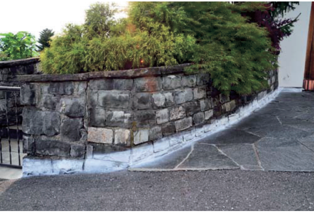
Abb. 2. Applikation selbsterodierender Silikatschichten auf eine Häuserwand zum Schutz vor Myriapoden.
