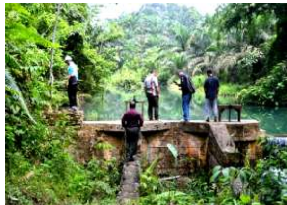
Gambar 2. Tim memeriksa bendungan (dam)
