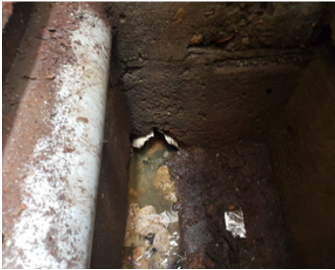
Figura 21. Tenemos la vista en planta de la caja 3 y se puede observar un tubo el cual descarga el agua de la rejilla.
