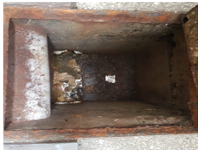
Figura 20. Tenemos la vista en planta de la caja 2 y se puede observar un tubo el cual descarga el agua de la rejilla.
