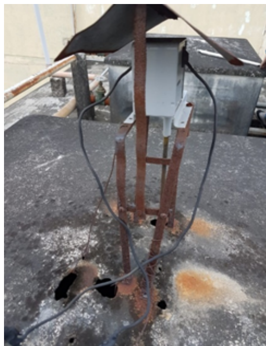
Figura 9. Sector correspondiente a nivelación. Boya de tanque de agua potable.
