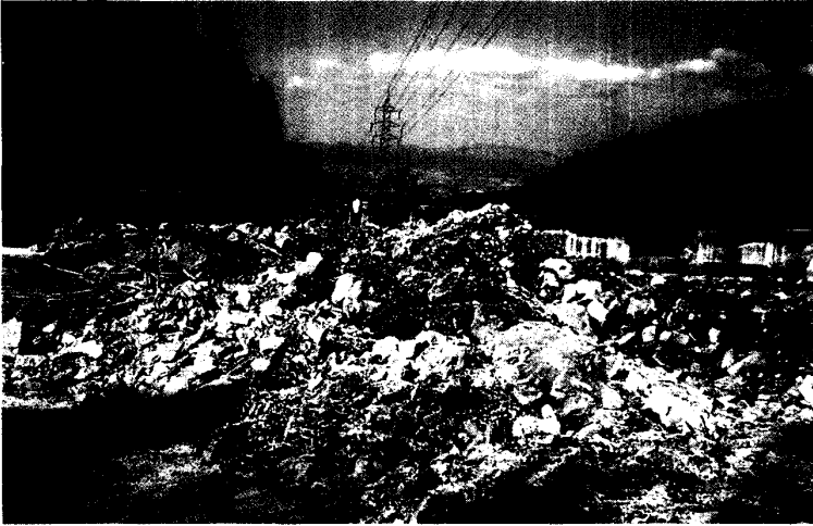
StT1の道路取付工事による変化 (1)
