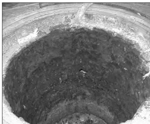
**Рис. 1.** Центральная солевая шахта ПНР кольцевого типа после 3-х месяцев эксплуатации (сталь 20, толщина стенок 40 мм)
