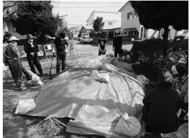
土嚢でシートを固定。この山2つ分の土を 取り除きました。
