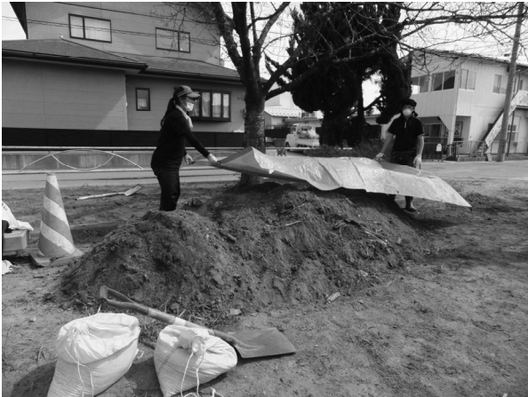
集めた土にビニールシートをかぶせて 乾燥した土が周囲に飛散ないようにします。
