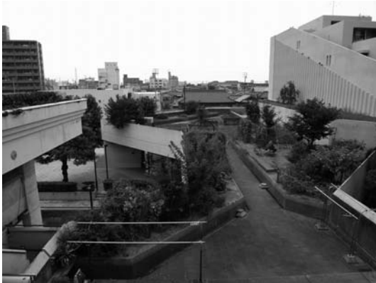
図1 坂出人工土地 市民会館の屋上にも市民住宅が設置されている。
