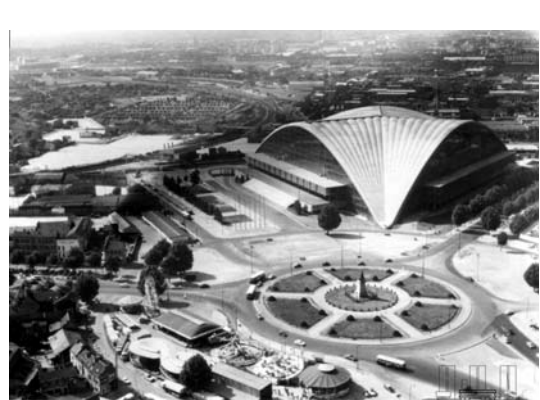
図4 建設当初の新産業技術センター
