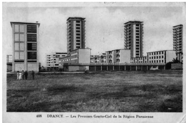
図21 建設当初のドランシーのシテ・ド・ラ・ミュエット
