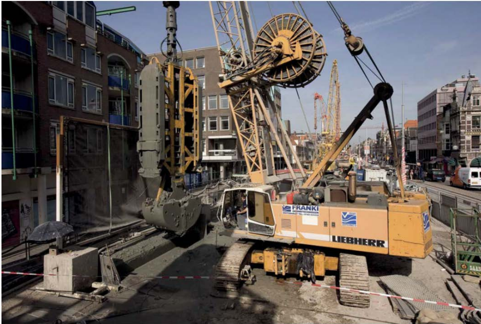
Fig. 3-1: Diaphragm wall construction in Vijzelgracht station (Korff, 2013)
