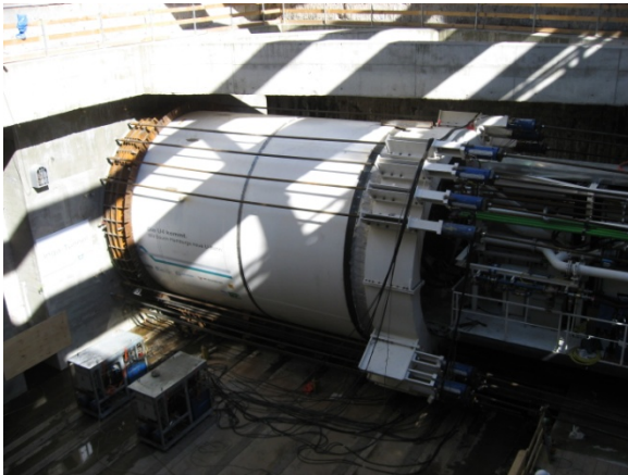
Abb. 13: Maschine inklusive Druckring
