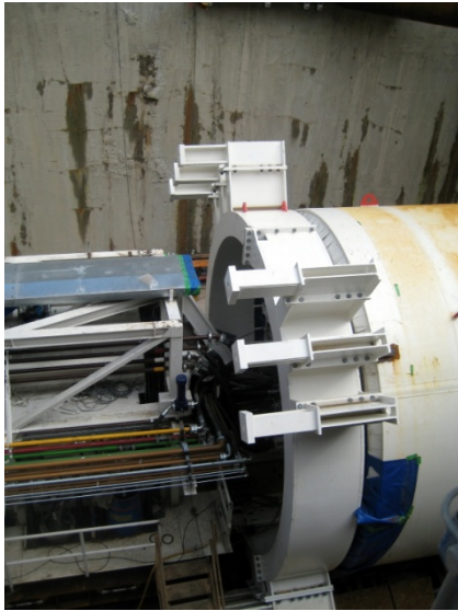
Abb. 17: Druckring XFEL
