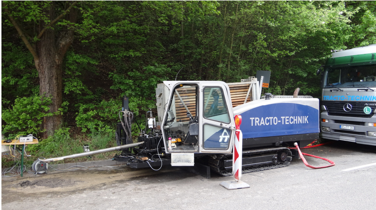
Abb. 1: Erster ORFEUS-Radarbohrkopftest unter Praxisbedingungen mit einer Grundodrill 15N - HDD-Bohranlage bei der grabenlosen Verlegung einer Erdgas-Leitung in Stuttgart-Vaihingen im Dachswaldgebiet
