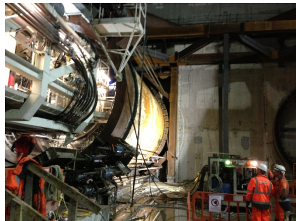
Abb. 20: Stahlbau und Anfahrtdichtung
