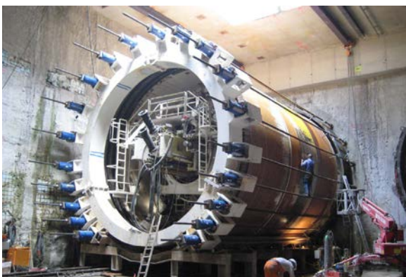
Abb. 11: Druckring mit Hohlkolbenpressen
