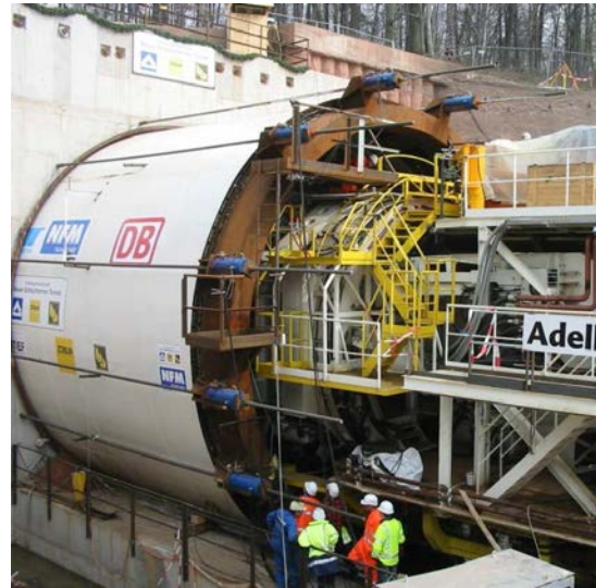
Abb. 10: Aufgebaute TBM
