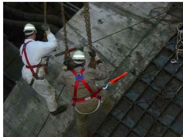
Abb. 2: Rückbaumaßnahmen der Blindringe
