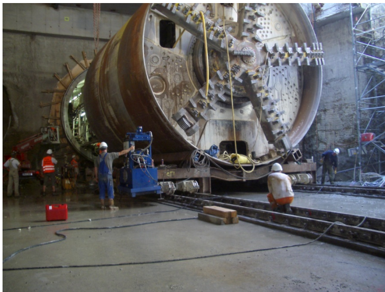
Abb. 21: TBM auf mobiler Schildwiege
