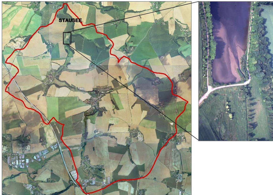
Abbildung 43: Untersuchungsgebiet Baderitzer Stausee (Datengrundlage: SLfUG 2002) und Mündungsbereich der Jahna in den Baderitzer Stausee mit deutlich sichtbaren Depositionsflächen – Situation 2002 (Foto F. Franzke)
