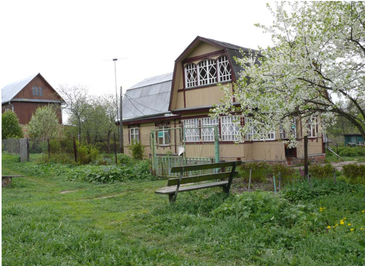
Abb. 6.12: Saniertes Wohnhaus eines Kleinbauern in Keptevo im Lubazhinkhaeinzugsgebiet
