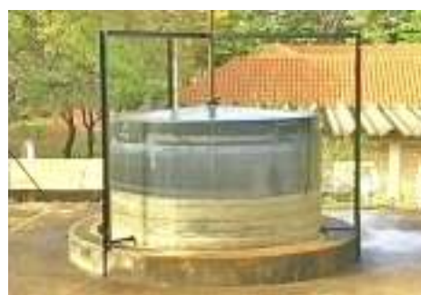
Figura 3 - Biodigestor de batelada Fonte - www.google.com.br/imgens
