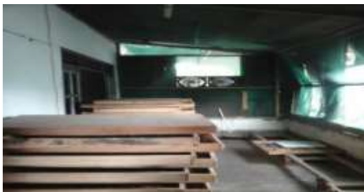
Gambar 7. Pemasangan 2 exhaust yang berfungsi menyedot udara panas dan memasukkan udara dingin ke dalam kandang
