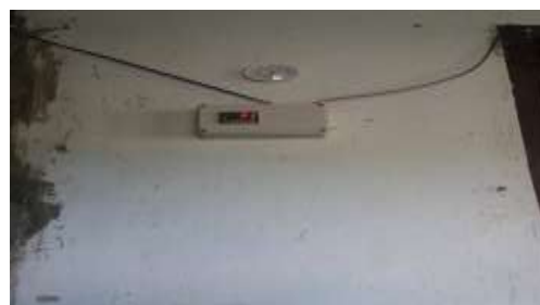
Gambar 8. Pemasangan termokopel (thermometer digital otomatis), yang terhubung dengan exhaust, sehingga ketika suhu melebihi 31 °C exhaust akan menyala otomatis
