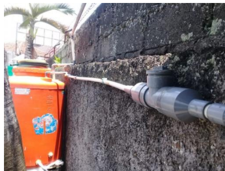
Gambar 1. Pemasangan klorinator
