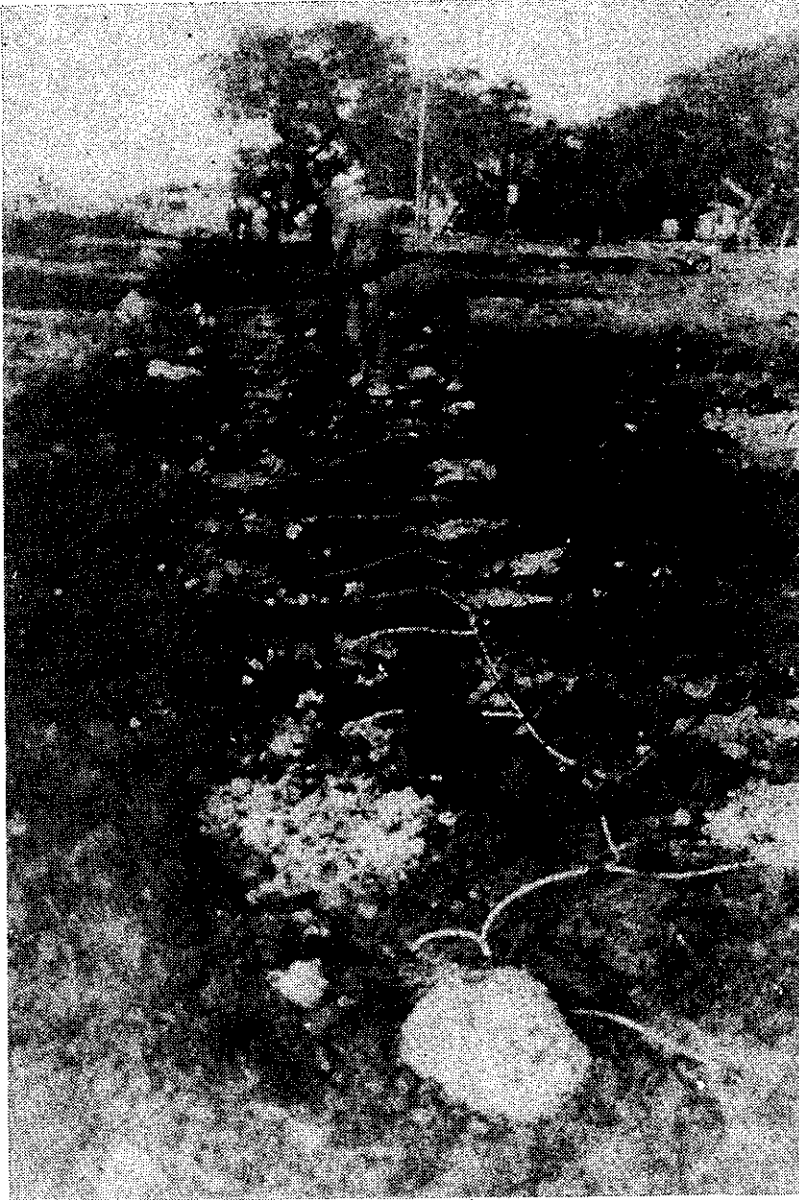
Rys. 13. Wsadzenie skał dla utworzenia rowu kablowego w pobliżu miejscowości Wollert w stanie Wiktorja
