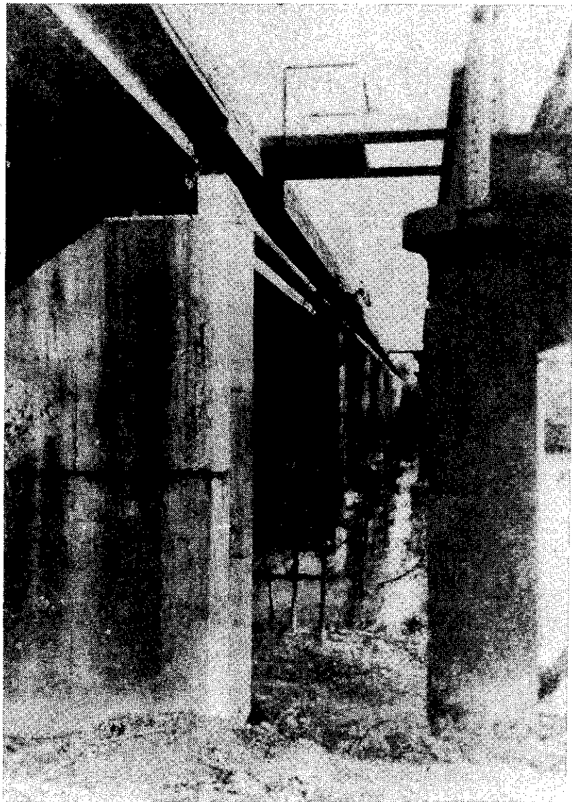
Rys. 20. Częściowy widok przejścia kabla rurą przez most kolejowy nad rzeką Goulburn w pobliżu Seymour
