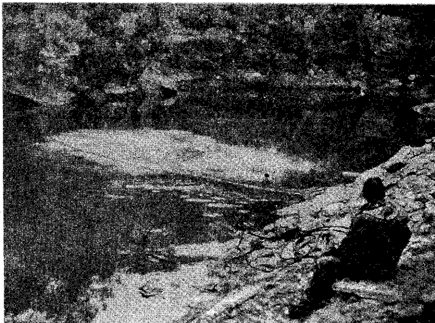
Rys. 21. Podwodne wysadzanie skał w dnie rzeki Nepean przez nurka w Douglas Park
