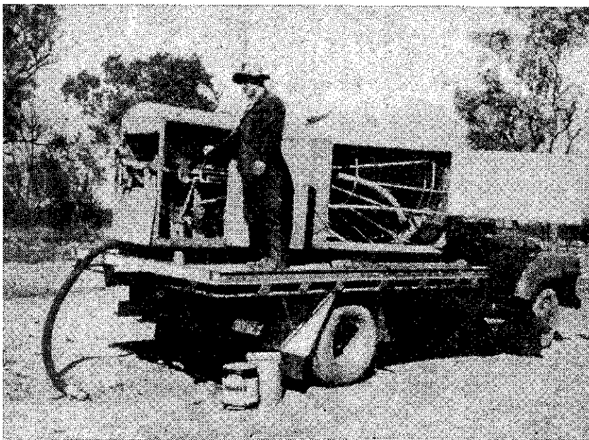
Rys. 24. Roductor - maszyna na samochodzie do przeciągania lasek przez kanalizację kablową
