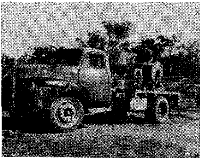
Rys. 23. Widok samochodu z wciągarką kabla do kanalizacji
