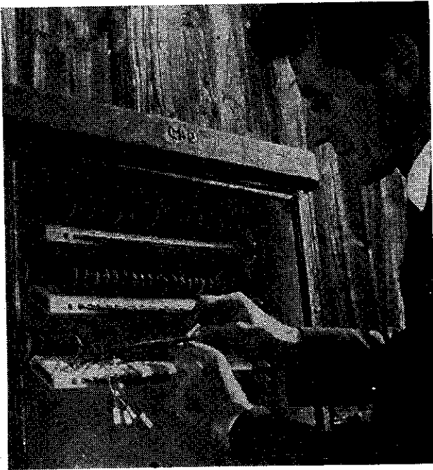
Rys. 1. Sprawdzanie połączeń w nowej doświadczalnej szafce kablowej. Każda półka w szafce może pomieścić 100 par kabli rozdzielczych i do 100 par kabla magistralnego
