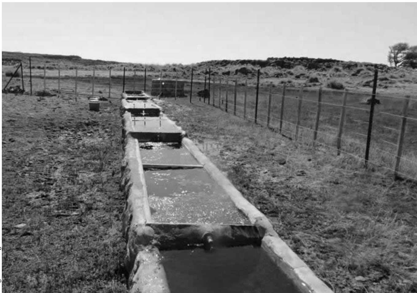
Figura 12. Cerco perimetral en la Laguna Antiñir, en el Parque y Reserva Nacional Laguna Blanca. En primer plano se observan los contenedores con agua instalados por fuera del cerco, para que el ganado abreve.
