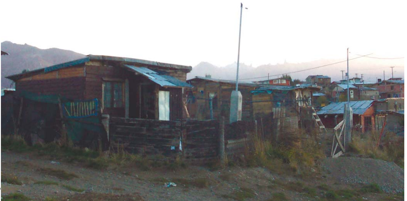
Viviendas familiares ubicadas al margen sur del barrio Arrayanes.
