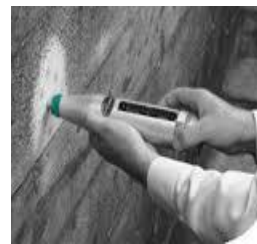
Fig – 3.2.1a) Rebound hammer
