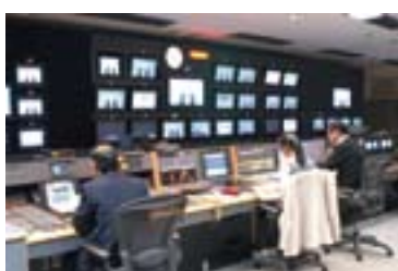
スタジオ副調整室
