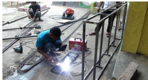
Gambar 1. Peserta melakukan pekerjaan las
