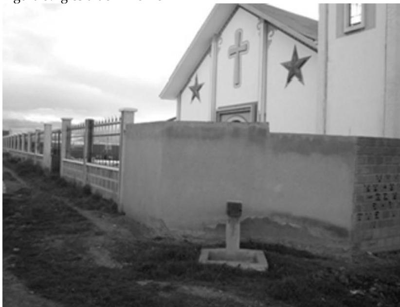
Figura 5. Iglesia de El Porvenir
