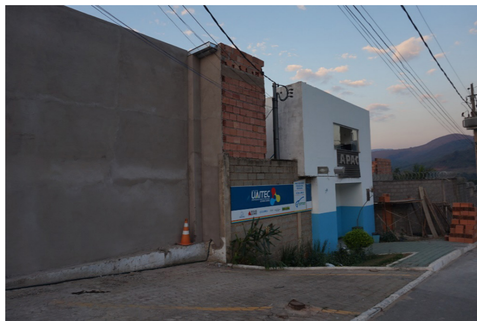
Figura 4 - Atual fachada da APAC Masculina de Nova Lima. Fonte: Autores.
