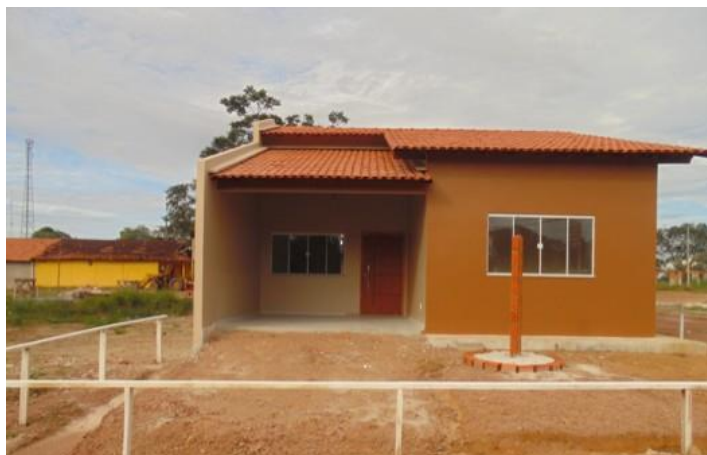
Figura 5: Unidade residencial edificada
