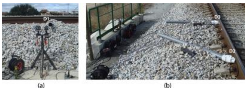
Figura 7: Pontos de apoio do sistema laser para medição do deslocamento do carril: (a) no maciço
