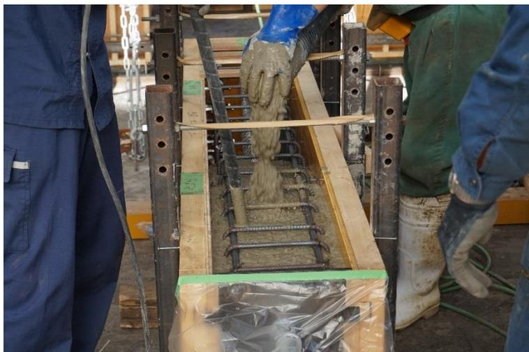
写真 2.1-3 コンクリート打設作業
