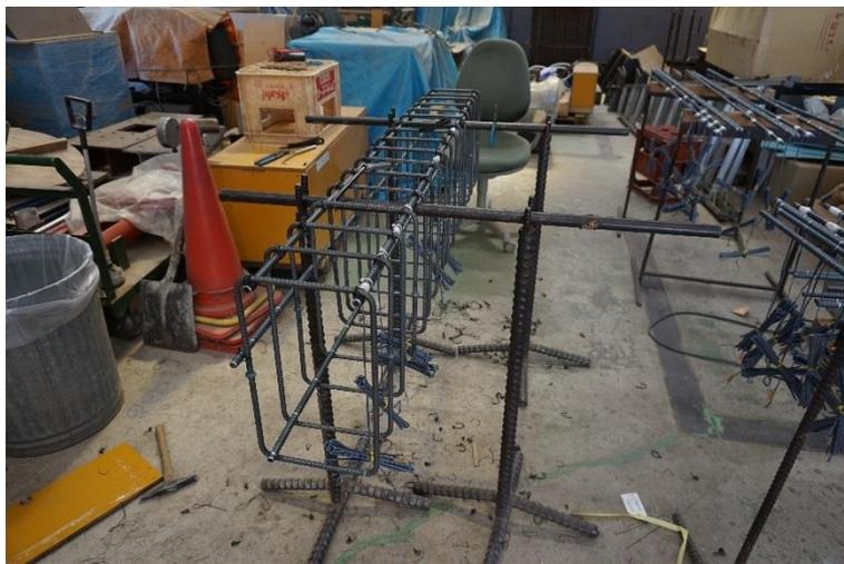
写真 2.1-2 鉄筋組み立て作業
