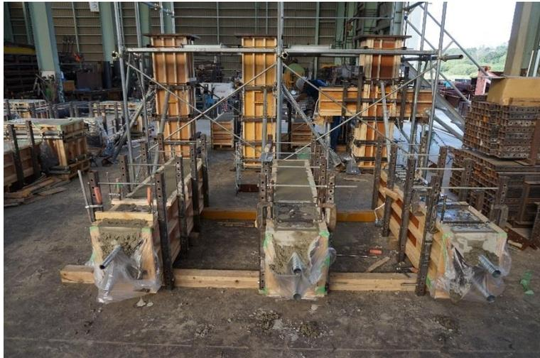
写真 2.1-4 コンクリート打設後
