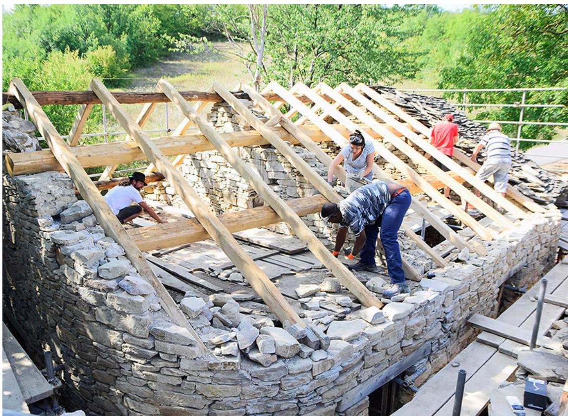
05. Banca del Fare. Rifacimento della copertura di un "ciabot" con materiali e tecniche tradizionali.
