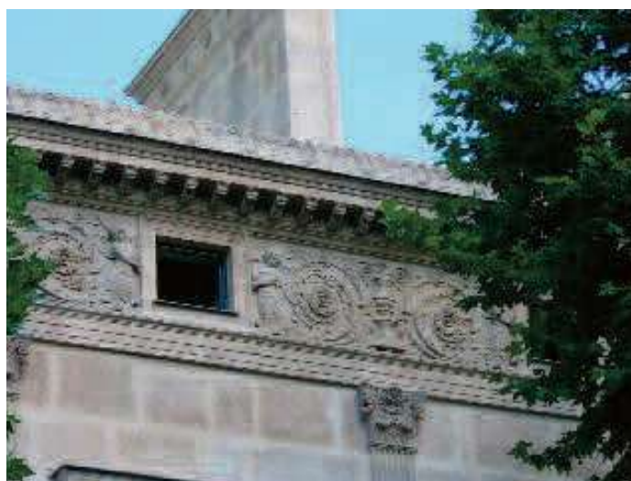
Fig. 14. Dettaglio della cornice, stato attuale.
