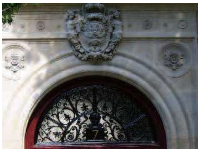
Fig. 15 Portale, stato attuale.
