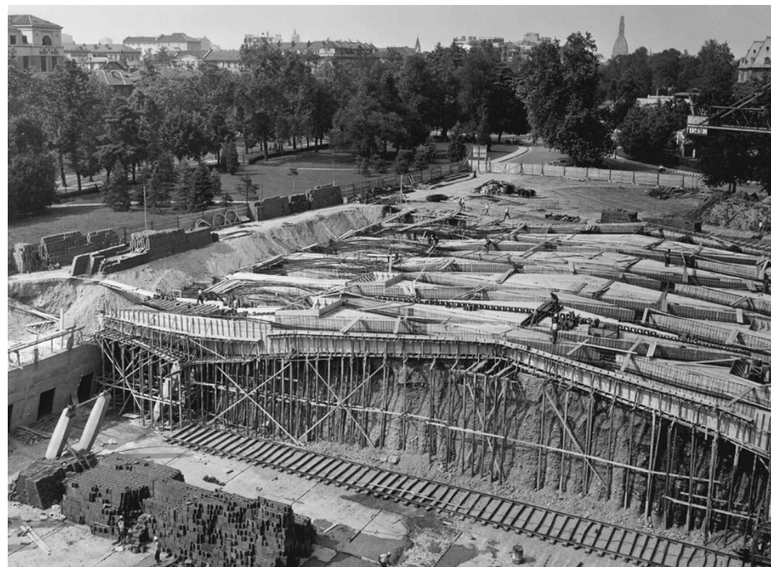
Figura 3 Immagine del cantiere. Fondo dell'archivio privato di Luigi Ravelli - direttore lavori presso il Servizio Costruzioni Fiat - al tempo della realizzazione del padiglione [Bruno, 2013].
