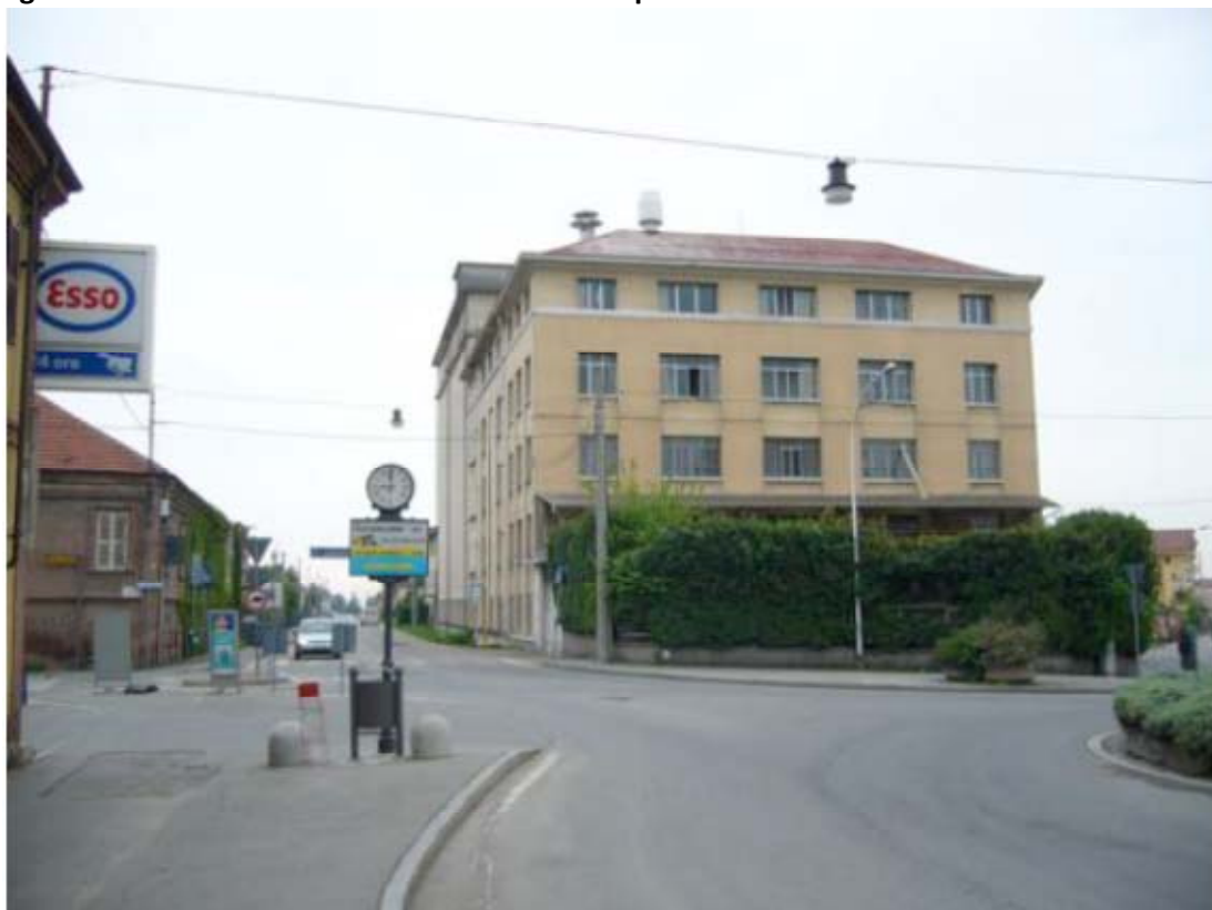
Figura 1 – Molino Berruto - vista nord-ovest da piazza Gialdo verso via Riva
