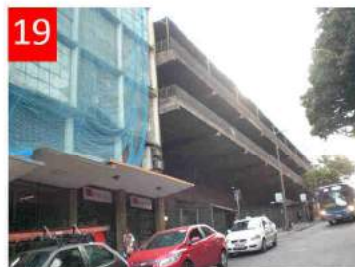
Rua dos caetes. Parcheggio pluripiano fuori terra
