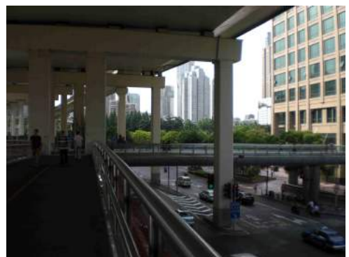
Fig.67. La North-South Elevated Road. In lontananza si scorge l'intersezione a sei livelli con la Yan'an Elevated Road. Fotografia dell'autore
