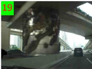
Yan'an Road. Il Dragon Pillar che sorregge gli svincoli di intersezione tra le due sopraelevate
