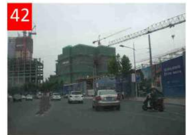
42 Dongdaming Road. Sul lato destro verso il fiume è stato demolito un cantiere navale e si costruisce un grande centro residenziale
