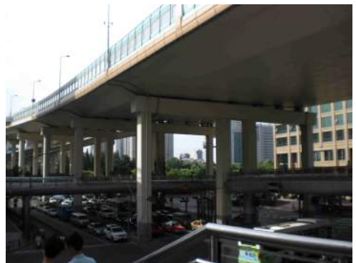
Fig.66. La North-south elevated road. Fotografia dell'autore
