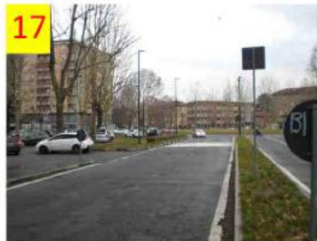
17 Piazza Rivoli vista da Corso Vittorio Emanuele II. Gli attraversamenti pedonali sono complessi e privi di impianti semaforici.
