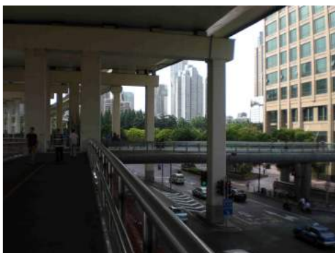
Fig.64. Chengdu Road. Le passerelle pedonali seguono il percorso della strada sopraelevata. Fotografia dell'autore
