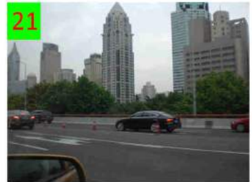
Yan'an Elevated Road in prossimità di People's Square
