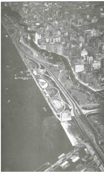
Fig. 94. Henry Hudson parkway, New York, 1937. La strada parco comincia a penetrare nelle città. In Sigfried Giedion, "Spazio, tempo ed architettura" Hoepli, Milano, 2010
