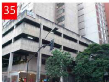
35 Parcheggio pluripiano in un edificio amministrativo ai margini di Praça Raul Soares
