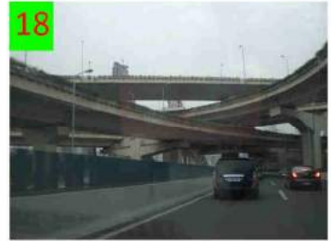
Yan'an Elevated Road. Terzo livello dal piano stradale
