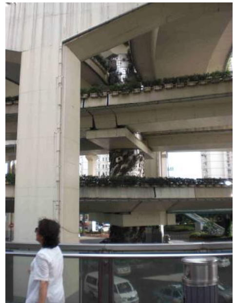
Fig.72. Il Dragon Pillar che sorregge i sei livelli stradali. Fotografia dell'autore
