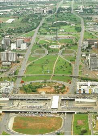
Fig.33.Il vasto parcheggio interno ad un piano elevato. Fotografia dell'autore
