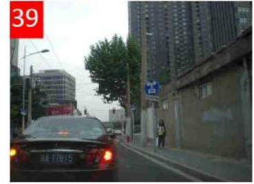
39 Gongping Road. Quest'area è in corso di demolizione e ricostruzione integrale
