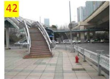
Yan'an Road. Le passerelle aeree non sono agevoli da affrontare se non in presenza di scale mobili, come nel caso della figura 12.
