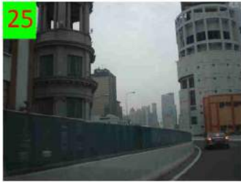
25 Yan'an elevated Road. A sinistra l'edificio visibile dal piano stradale in fig.73
