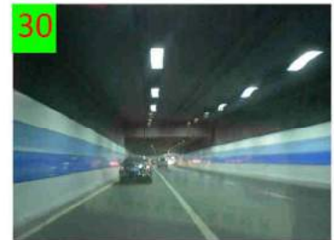
30 Il Bund tunnel in direzione nord
