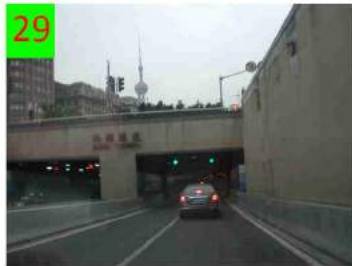
29 Ingresso del Bund Tunnel
