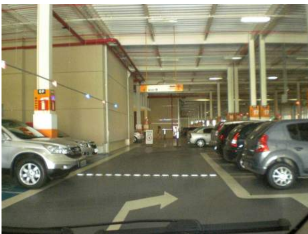
Fig.26. Il vasto parcheggio interno ad un piano elevato. Fotografia dell'autore
