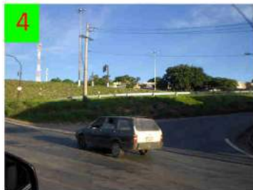
Svincolo di immissione dalla Avenida Amazonas per l'Anel Rodoviario
