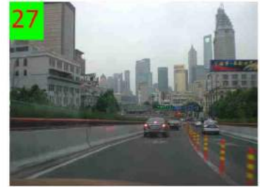
27 La strada scende per raggiungere il Bund Tunnel
