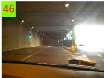
46 Il sottopasso era in origine un tunnel ferroviario che collegava due distretti industriali. Dopo la sua dismissione rimase a lungo abbandonato e poi convertito in Tunnel stradale
