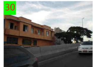
30 Sopraelevata che supera la ferrovia e la MG-050
