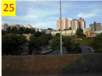
25 Cavalcavia in prossimità della strada statale MG-050, che inizia a Belo Horizonte e termina a San Paolo
