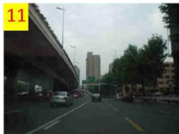
Yan'an Road. La strada è alberata per minimizzare la vista della sopraelevata dagli edifici adiacenti
