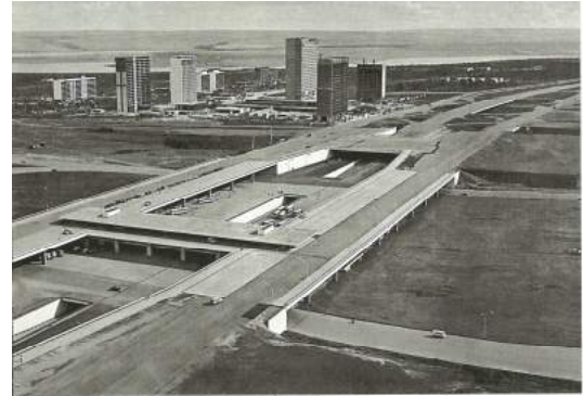
Fig.34.Il vasto parcheggio interno ad un piano elevato. Fotografia dell'autore
