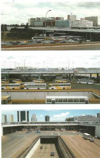
Fig.35.Il vasto parcheggio interno ad un piano elevato.Fotografia dell'autore
