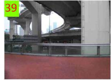
Passerelle pedonali del Dragon Pillar, all'intersezione delle due sopraelevate.
