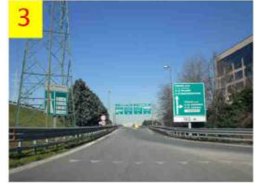
3 Ingresso della Tangenziale sud
