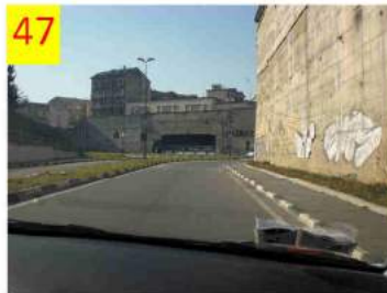
47 Di fronte si intravede la continuazione del tunnel ferroviario, ancora abbandonato
