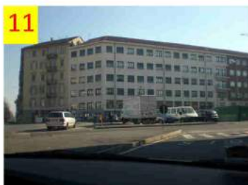
11 Corso Principe Oddone. La ferrovia è di recente stata interrata e si prevede un ampliamento del Corso
