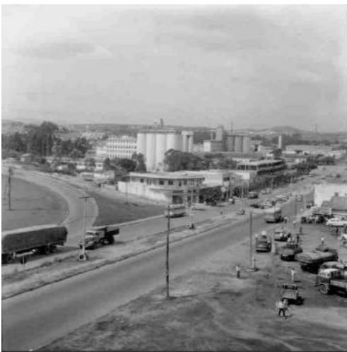
Fig.11. Avenida Amazonas e la città industriale verso la metà degli anni 60. Museu Histórico Abílio Barreto - Prefeitura municipal de Belo Horizonte.
