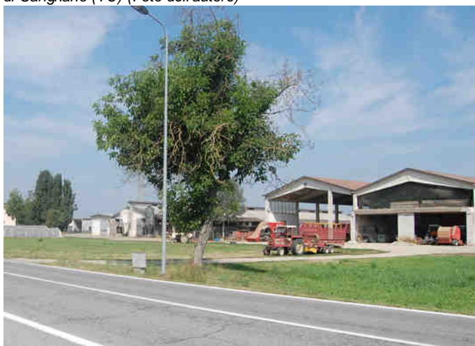
Fig.21 – Struttura agricola di recente costruzione per il ricovero dei mezzi agricoli nei pressi di Casalgrasso (TO) (Foto dell'autore)
