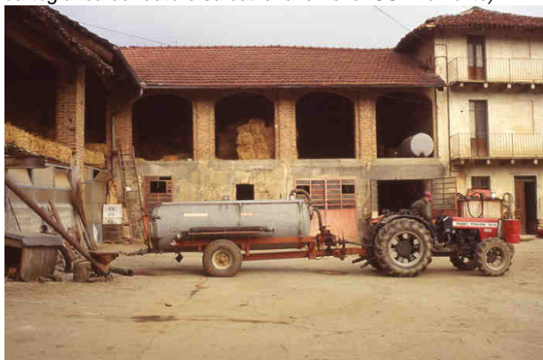
Fig.63 - Cascina a corte chiusa (Fonte: Archivio Regione Piemonte - Direzione Agricoltura). Si tratta di un fattore qualificante del paesaggio rurale tradizionale piemontese, un patrimonio architettonico sottovalutato, talvolta fagocitato da fenomeni insediativi e infrastrutturali.
