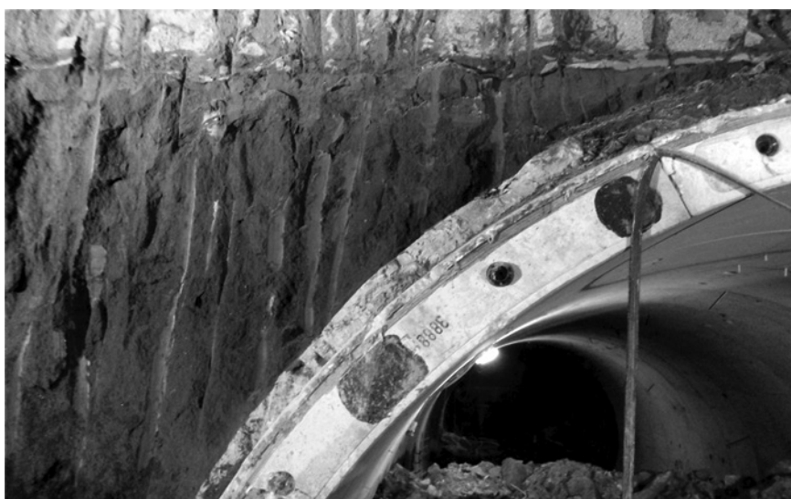
Fig. 2. Hardened two component mix below the segments and the soil as shown in the excavation of the station Centocelle. (photo Mapei's archive). Miscela indurita tra i conci ed il terreno come appare nello scavo della stazione di Centocelle (fotografia archivio Mapei).
