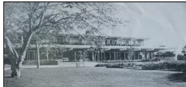
Fachada principal donde al fondo de la residencia construida en el Country Club por los arquitectos Neutra, Álvarez y Gutiérrez.
