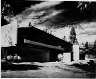
Angulo Sur-Oeste de la residencia. Garaje para tres automóviles bajo el ala oeste. Escalera de entrada a la derecha. Un muro blanco evita la vista directa sobre el estar desde la escalera de entrada.
