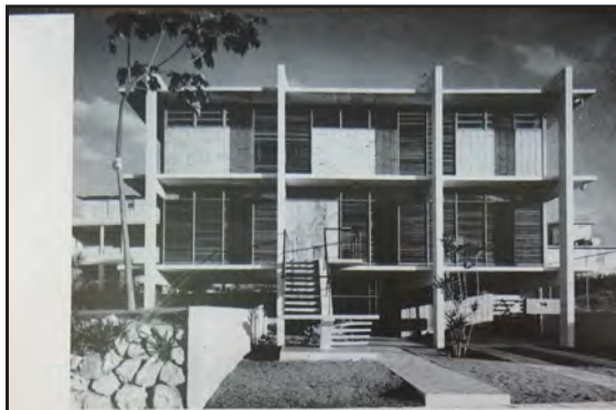
Fachada principal con la entrada del garage.
