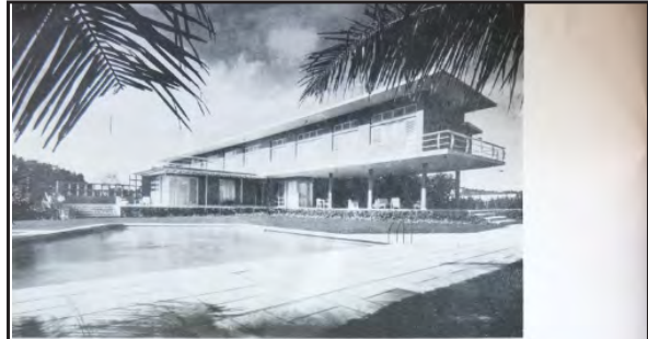
VISTA DESDE LA PISCINA DE LA RESIDENCIA CONSTRUIDA EN EL 'COUNTRY' CLUB PARA LA FAMILIA CUETO DE LA NOVAL. ARQUITECTOS SILVERIO BOSCH Y MARIO ROMAÑACH.
