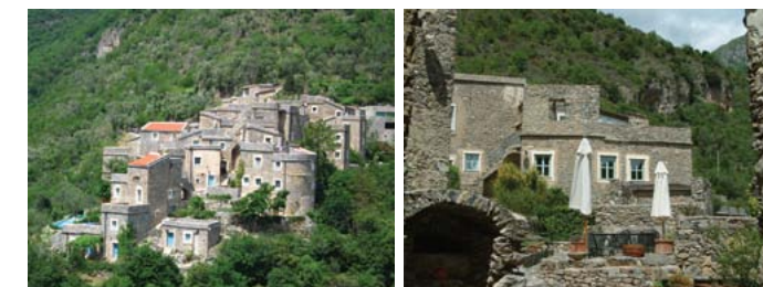
[Figg. 41-42 - 1991/1998 - Colletta di Castelbianco, Castelbianco, valle Pennavaira (SV), 300 m s.l.m. Ristrutturazione e rifunzionalizzazione dell'intero borgo ad opera di un'unica società. Progettista: Giancarlo de Carlo. Elementi caratterizzanti:
