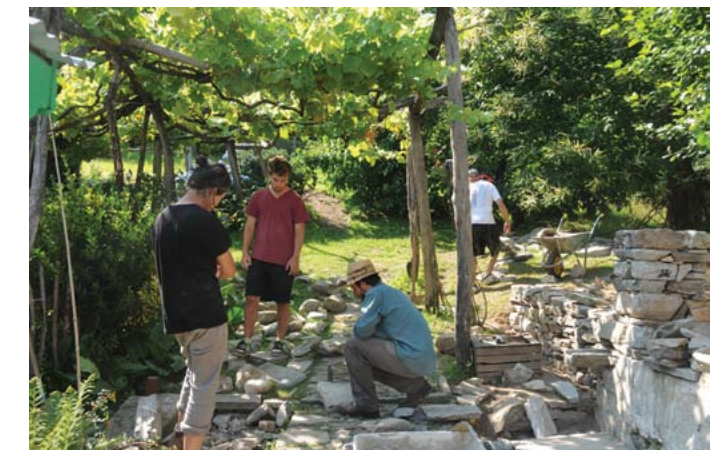
[Fig. 21 - workshop organizzato dalla Associazione Canova sulla costruzione di case in pietra - Crevoladossola (VB) - foto Francesco Stassi]
