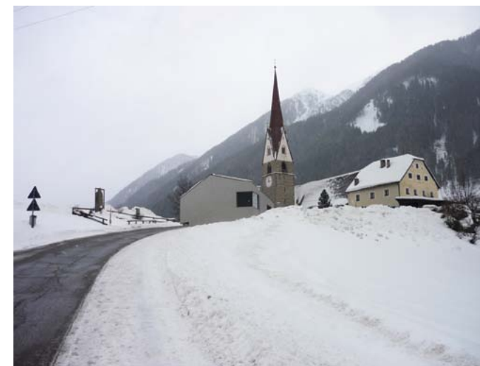
[Fig. 20 - edificio polifunzionale "am Buhel", architetti Mutschlechner & Mahlknecht - Comune di S. Giacomo - Valle Aurina (BZ) - foto Nadia Battaglio]
