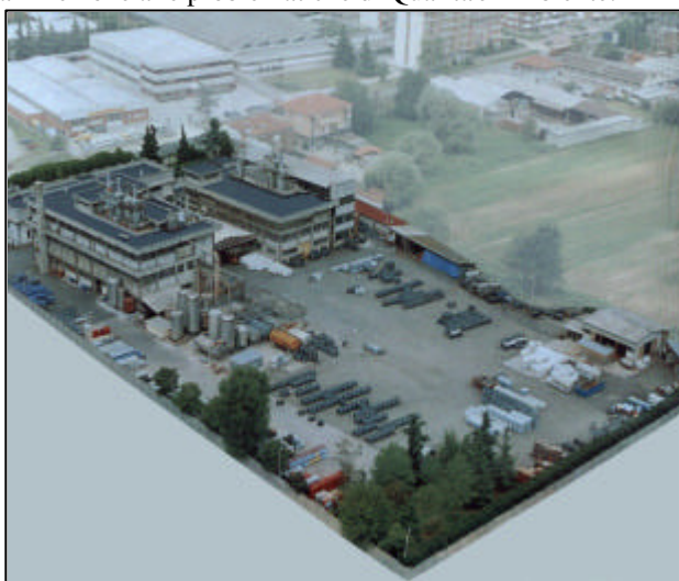
Figura 1 - Veduta aerea della SEICI S.p.A.
