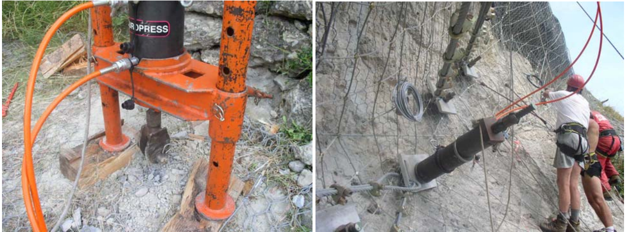
Fig. 3. Particolare di prova di sfilamento su cavi di controventatura (a sinistra) e di prova di tiro su barre di ancoraggio in parete al si sotto dello sperone del "naso" (a destra).
