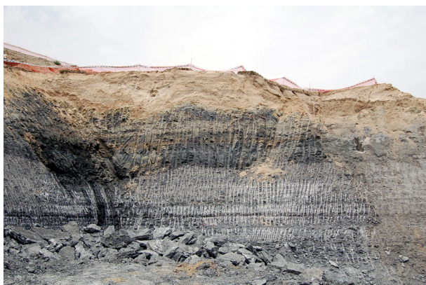
Fig. 4.—Estratigrafía del frente este del vaciado del Estanque de Tormentas de Butarque. En la parte inferior los yesos tableados y masivos miocenos y a su techo el residuo kárstico in situ por disolución de los yesos infrayacentes (edad Pleistoceno Medio, Uribe Larrea, 2008). En posición superior el muro arenoso de la secuencia 3 depositada por el río Manzanares, contiene a su techo el yacimiento H-03 de Domínguez-Alonso et al. (2009, Fig. 2).
