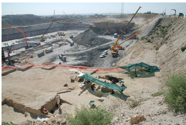
Fig. 3.—Trabajos de vaciado del Estanque de Tormentas de Butarque (ETB) durante los años 2006-2007, y excavaciones arqueológicas en las secuencias 2 y 3 de Domínguez Alonso et al. (2009; Fig. 2). En primer término el yacimiento H-02, situado en la secuencia 2.
