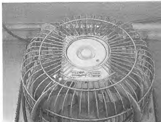
写真F 2 漏れ防止の為に工業用有圧換気扇 (羽根径 35cm) に強化された喫煙室
