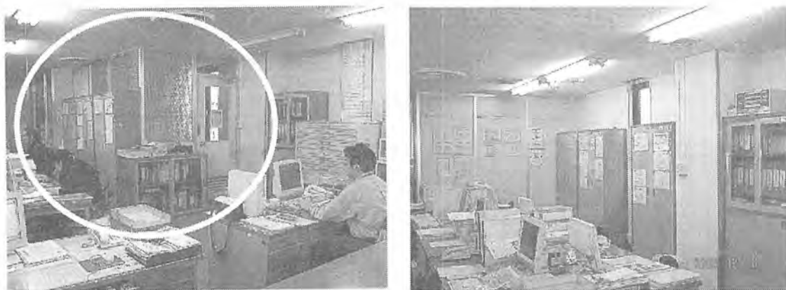
写真 B 3 本事務所の喫煙室 撤去前（左）、撤去後（右）
