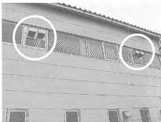
写真B5 左：窓に新設された換気扇（平成12年）、右：増設された排気装置（平成15年）
