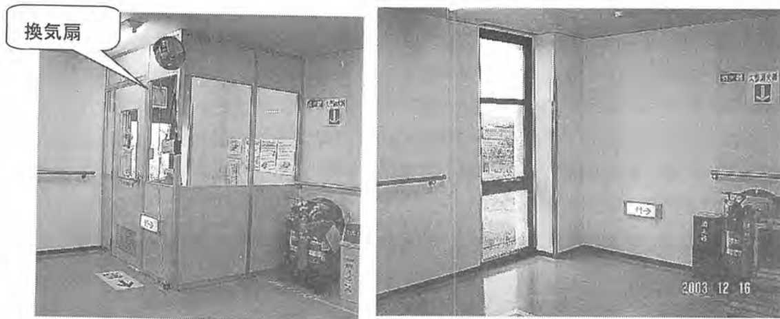
写真 B 2 工場棟の喫煙室 撤去前（左）、撤去後（右）
