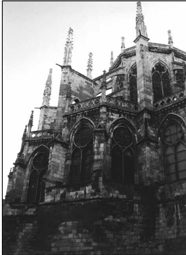
Figura 2. Ábside de la catedral de León en el que se pueden identificar los tipos de piedra que forman la fábrica. Figure 2. Leon cathedral apse showing different types of stone.
