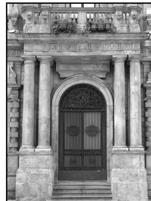
Figura 6. Portal del Palacio de Marino (G. Alessi, 1572): zócalo, plintos, columnas y entablamento de Ceppo (conglomerado y arenisca).
