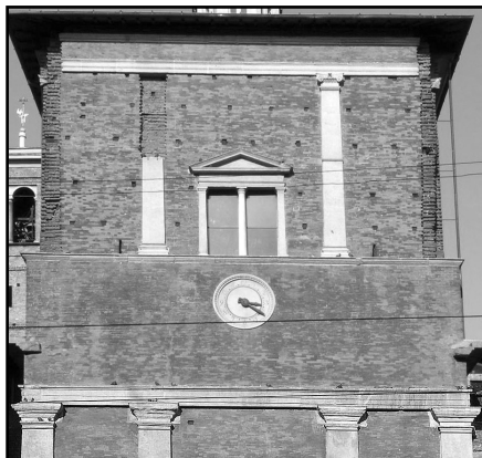
Figura 5. Capilla de Trivulzio (Bramantino, 1512): pilastras de granito de Montorfano y muros de ladrillo.
