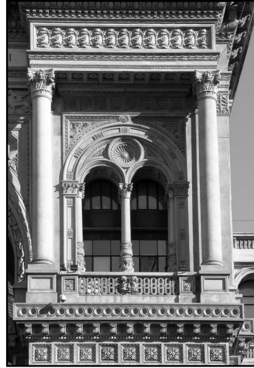
Figura 10. Galleria Vittorio Emanuele II (G. Mengoni, 1878): detalle de las columnas de caliza de Viggiù y de Saltrio, de granito de Baveno (fustes) y de mármol de Carrara (capiteles).
