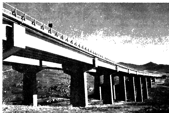
Fig. 1.—Vista general del viaducto.
