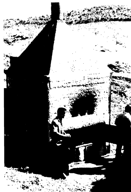
Figura 4.- Incinerador experimental construido en Sagua la Grande. Cuba.
